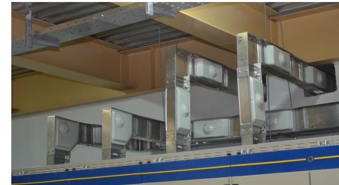
Вводная панель ГРЩ "Оскол" с подводом шинопровода сверху и отводом кабелей снизу
