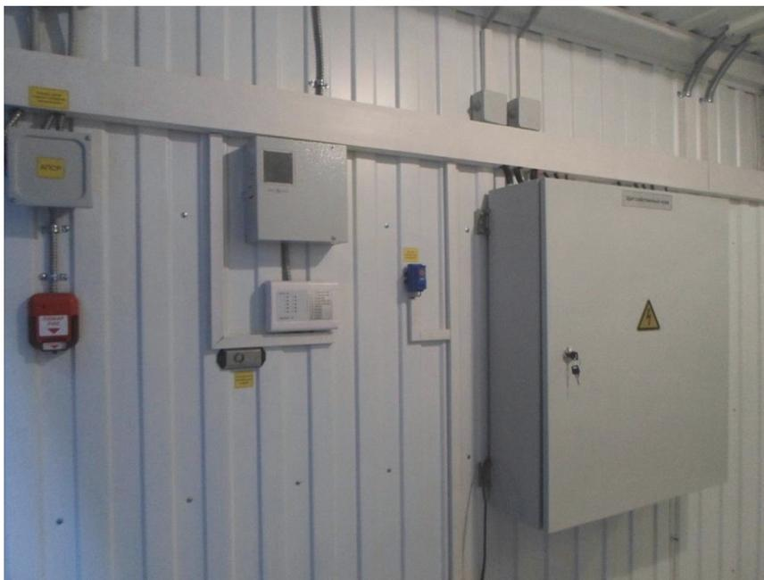
Рис. 7.1 Пример комплектации охранно-пожарной сигнализации
