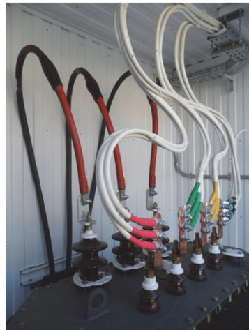
Рис. 4.2.1 Подключение силового трансформатора
