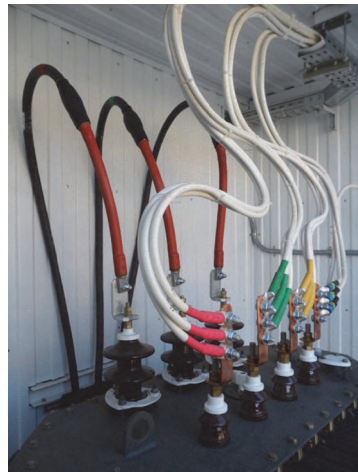
Рис. 4.2.1 Подключение силового трансформатора
