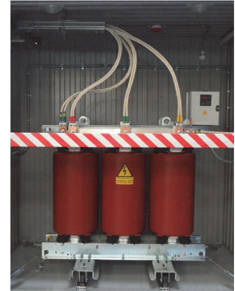
Рис. 4.2.2 Компоновка трансформаторного отсека
