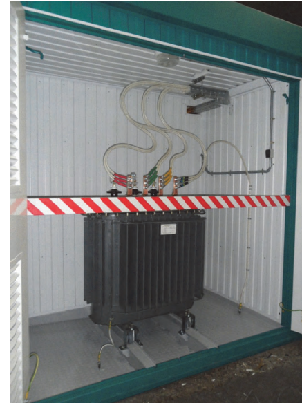
Рис. 4.2.2 Компоновка трансформаторного отсека
