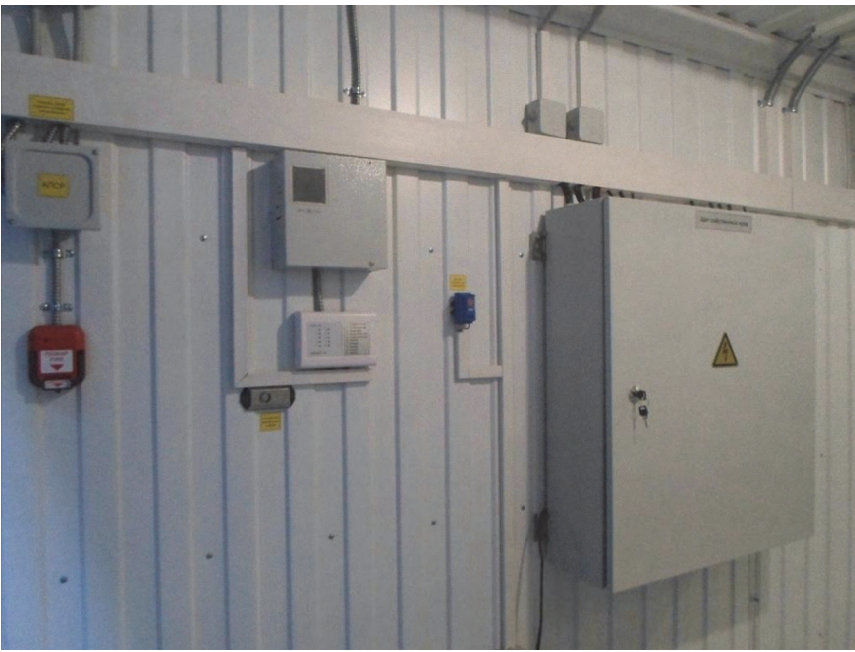
Рис. 7.1 Пример комплектации охранно-пожарной сигнализации
