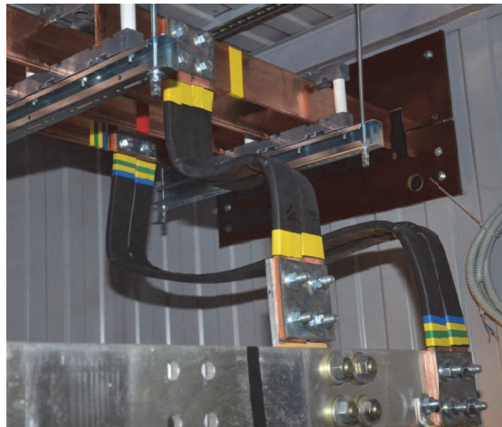
Рис. 4.2.1 Подключение силового трансформатора
