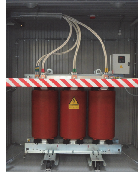
Рис. 4.2.2 Компоновка трансформаторного отсека
