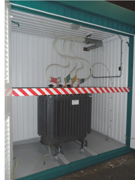
Рис. 4.2.2 Компоновка трансформаторного отсека
