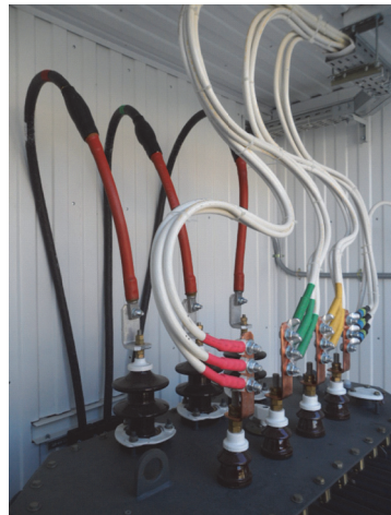
Рис. 4.2.1 Подключение силового трансформатора
