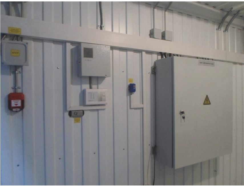
Рис. 7.1 Пример комплектации охранно-пожарной сигнализации
