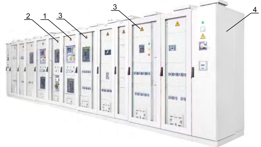
Главный распределительный щит ГРЩ "Оскол" двустороннего обслуживания
